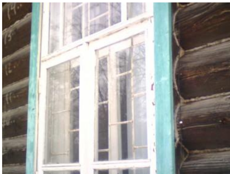
Рис. П.2. Наружные ограждающие конструкции в хорошем состоянии, температурные перепады связаны с нарушением переплетов оконных проемов.
